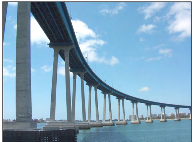
San Diego-Coronado Bridge
