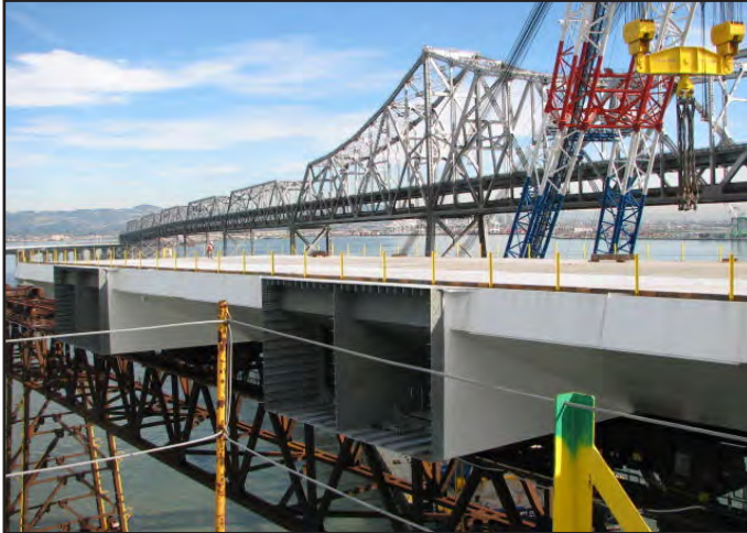
SAS Roadway Box 9E in Place
